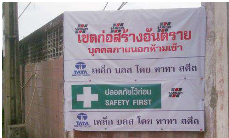
ภาพที่ 6-5 ป้ายเตือนการก่อสร้างหรือต่อเติมอาคาร
