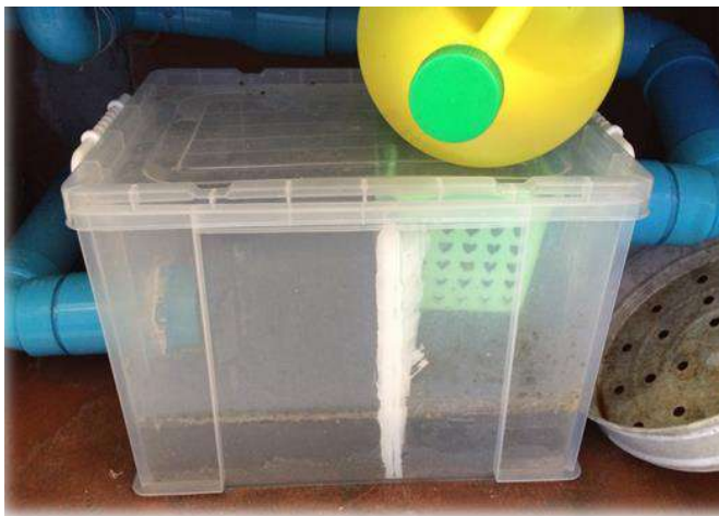
ภาพที่ 5-18 ตัวอย่างบ่อดักไขมันประดิษฐ์อย่างง่าย ของสำนักเทศบาลมาบอำมฤต จังหวัดชุมพร
